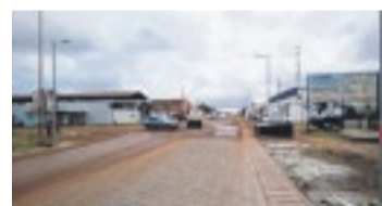
Les travaux de la route du port industriel piétinent.
