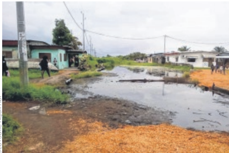
Des travaux plus importants s'imposent pour faire face aux inondations.
