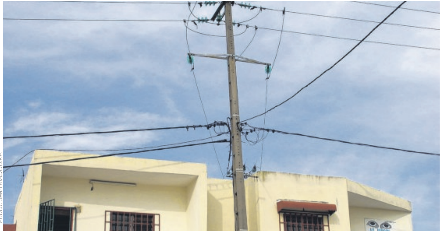
Cette habitation dans un quartier de Libreville tutoie quasiment la haute tension électrique.
