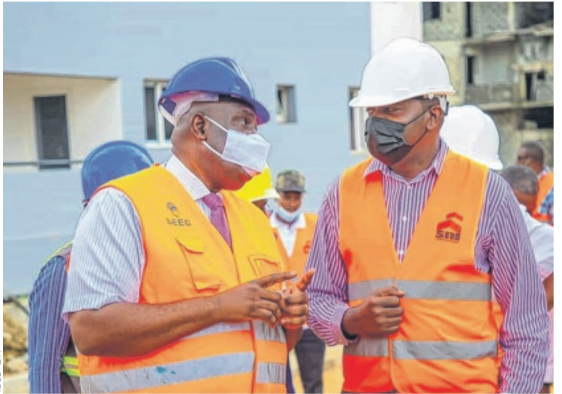
Photo: DR Les DG de la Sni et de la SEEG, sur le site des Parasoliers, pour voir l'avancement des travaux de raccordement en électricité et en eau.
