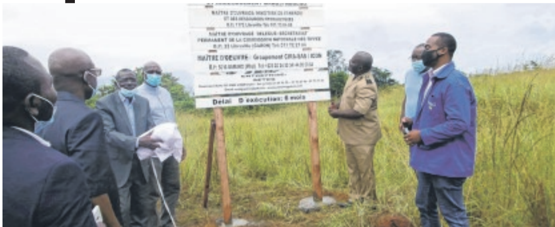
Les autorités locales de Mandji-Ndolou lançant officiellement les travaux.
