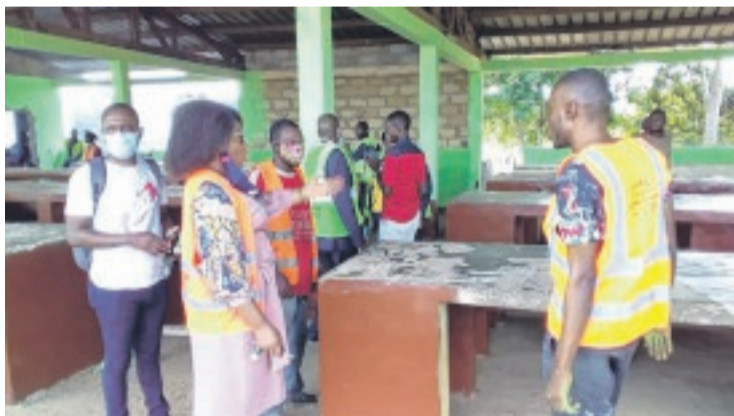
La mairesse Elodie Diane Sandjo sur le chantier de la réfection du marché de Mangoungou.
