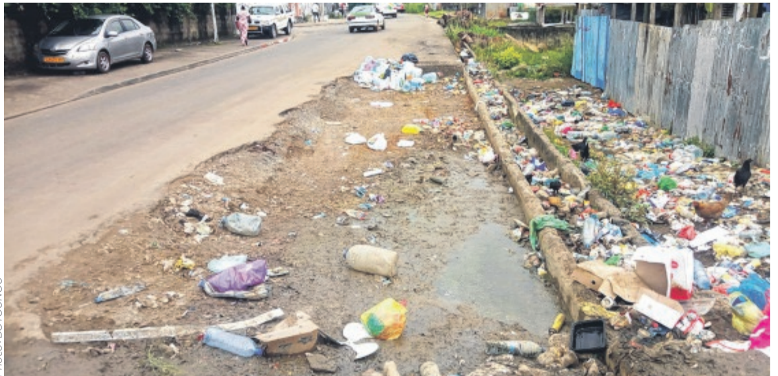
Une partie de la voie complètement défoncée après plusieurs opérations de ramassage des ordures à la tractopelle.
