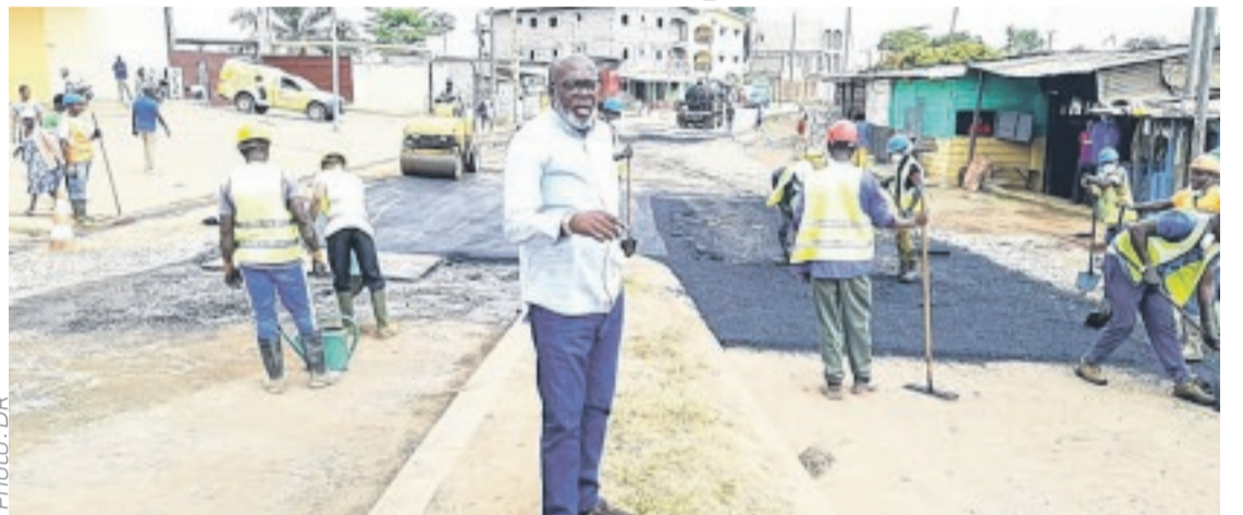
Le maire d'Oyem, Christian Abessolo Menguey, visitant les travaux dans sa ville.
