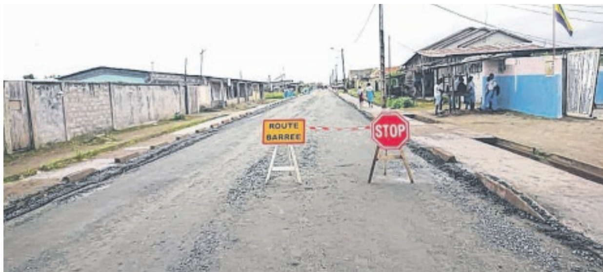
Une vue de la route en travaux.
