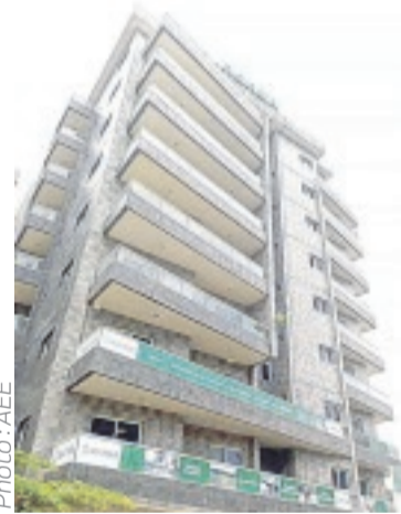
Le bâtiment abritant les services de l'Agasa à Batterie-IV.
