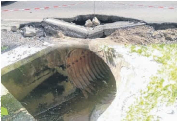
Effondrement de la buse au niveau du Mess de l'Armée de l'air.
