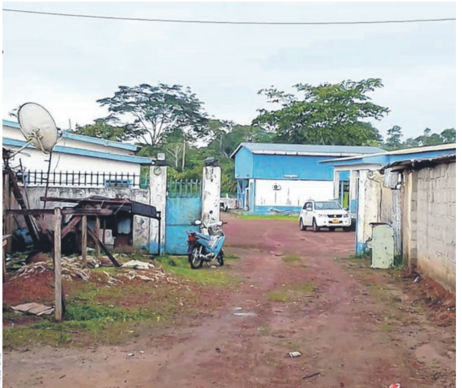
Les installations de la SEEG ne semblent plus supporter la charge des quartiers de Mekambo.
