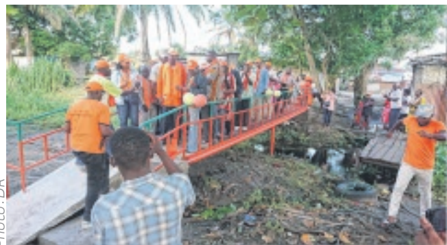
Le nouvel ouvrage à côté de l'ancien, un ouf de soulagement pour les riverains
