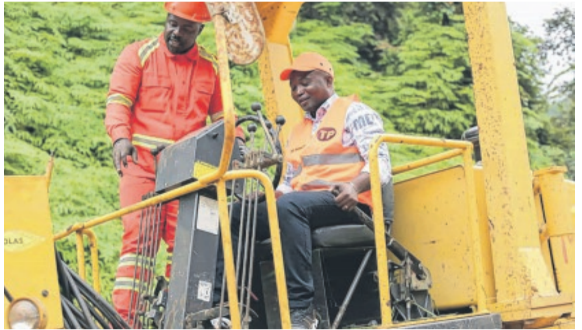
Une phase du lancement des travaux par le ministre Emmanuel Eyeghe Nze.
