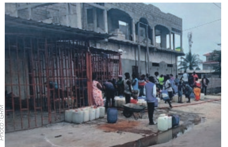
Retour de l'alimentation en eau potable au quartier Côte-d'Azur à Port-Gentil.
