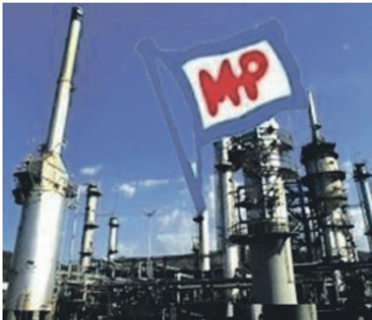
Des installations du groupe MP.
