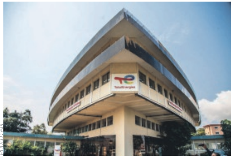
Le siège de TotalEnergies à Port-Gentil.
