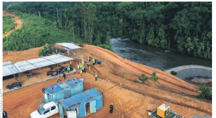
Le chantier en construction du barrage hydroélectrique de Kinguelé-Aval.
