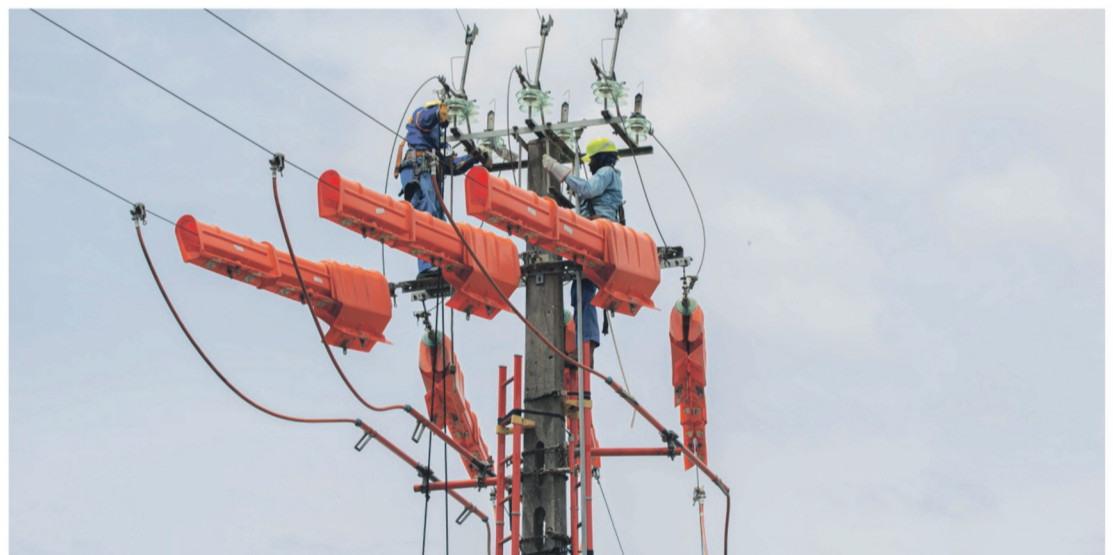
Electriciens en intervention sur le réseau de distribution
