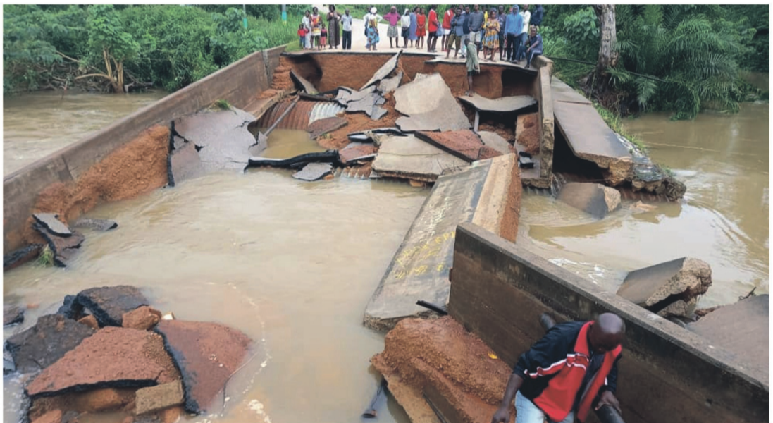
L'effondrement du pont sur la rivière Mougoutsi à l'origine du manque d'eau à Tchibanga
