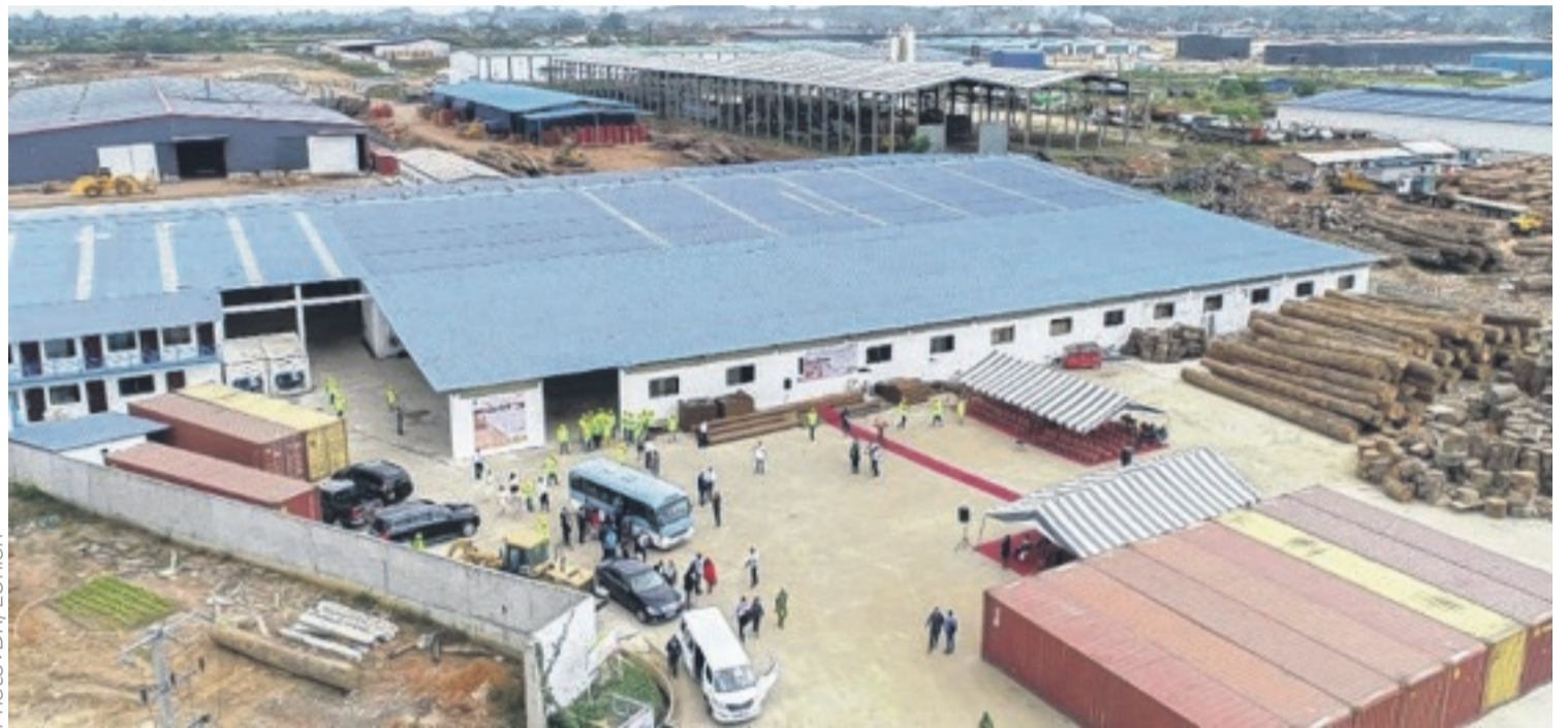
Une usine de transformation du bois.
