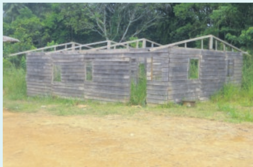
Une vue du logement en construction, depuis des années, du directeur de l'école d'Angouma.
