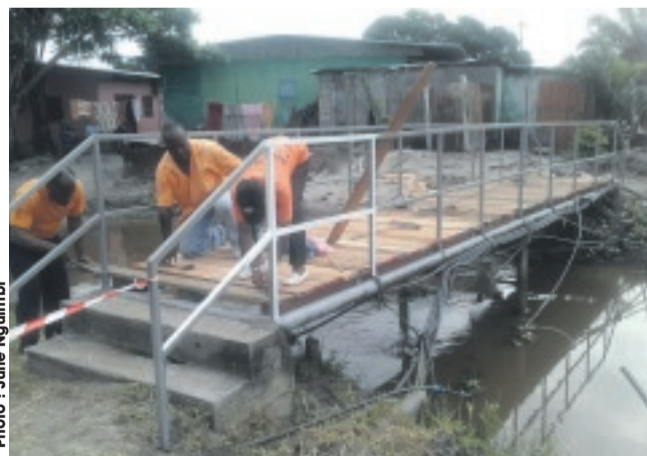
Les militants à pied d'œuvre pour la réhabilitation totale de la passerelle sur le canal Masuku.
