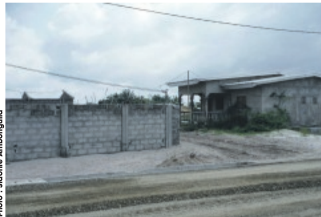
Des bâtisses modernes sortent de terre.
