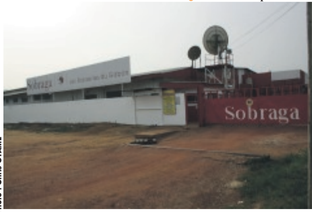
L'usine de Sobraga est installée dans le quartier Angone 1, à Oyem.
