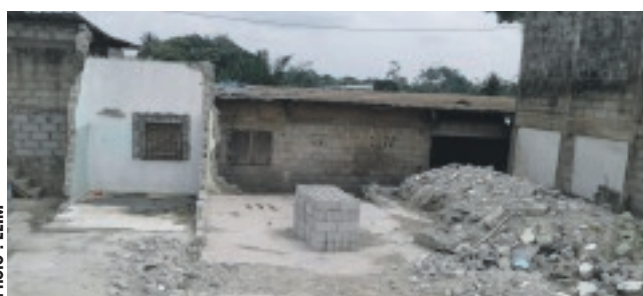
Des murs rongés et des tas de gravats, comme dans une ville-fantôme.
