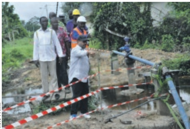
La visite des tuyaux posés dans le cadre du réseau de distribution d'eau dans tout le quartier.
