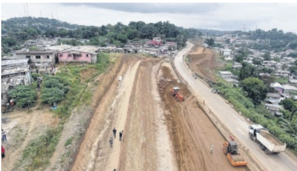
Les travaux du tronçon routier PK5-PK12 avancent.
