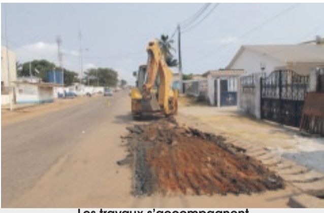
Les travaux s'accompagnent de l'assainissement.
