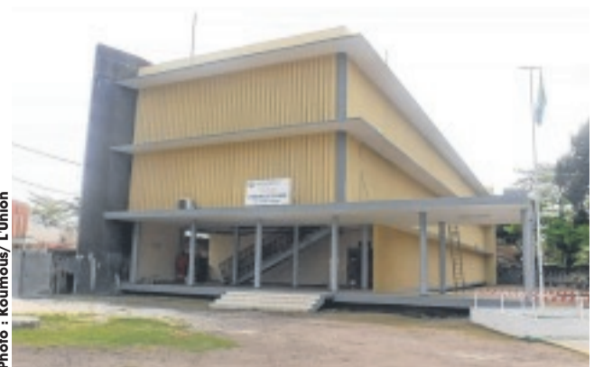
La préfecture en cours de rénovation.
