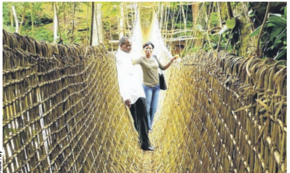
Pour certains, il faut s'armer de courage pour emprunter l'ouvrage.
