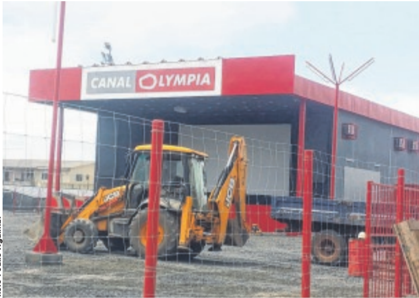
Un bull effectuant des travaux de terrassement.
