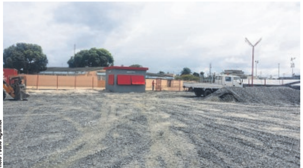
La cour de Canal Olympia subit encore quelques travaux de retouches.
