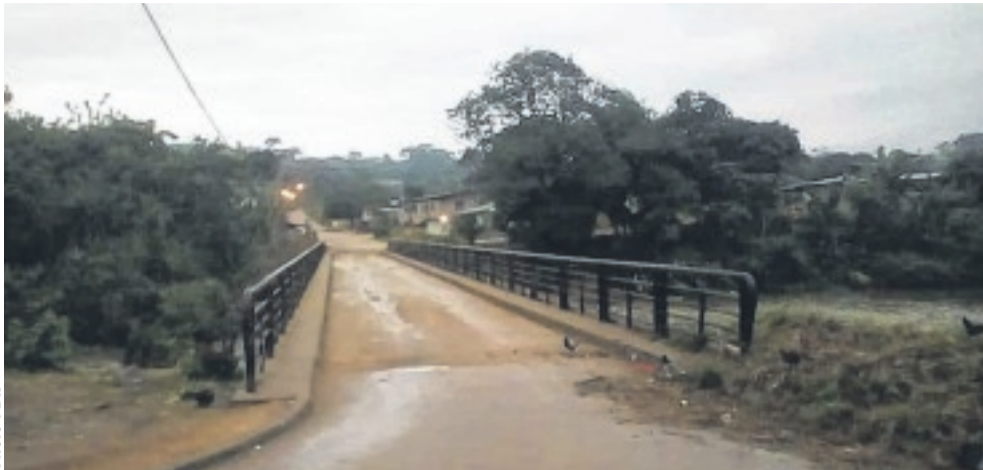
C'est dans les environs du pont Mibaka que la dépouille du garçon a été découverte.
