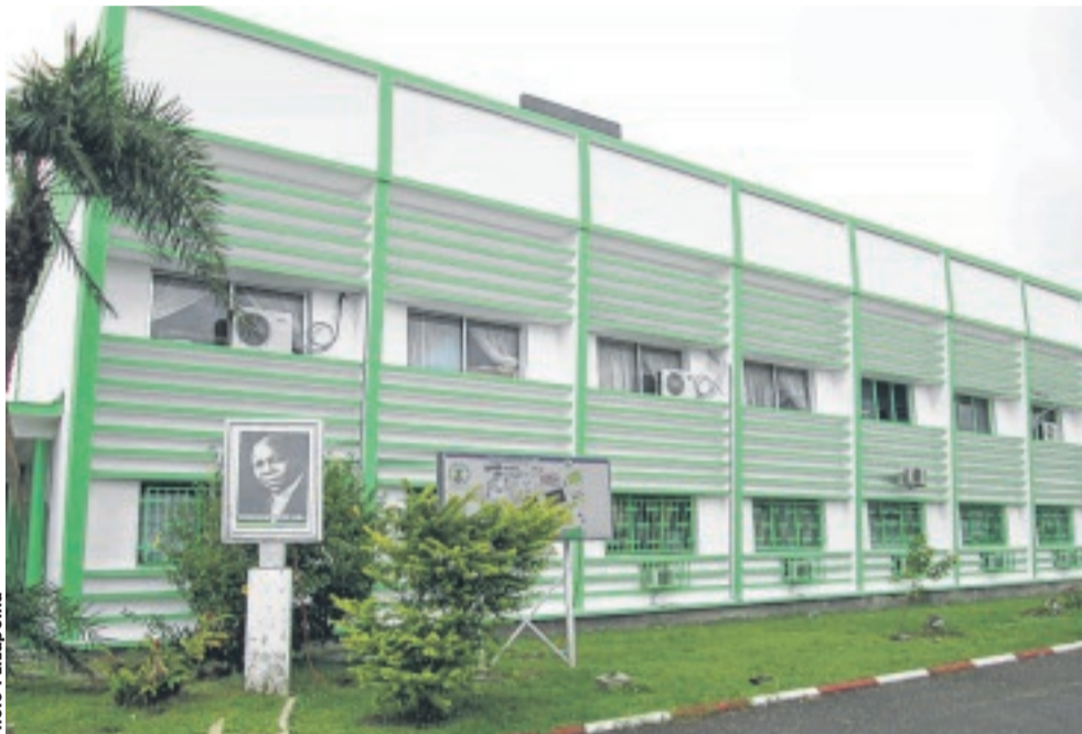
Le Lycée Mba réhabilité par Mvê-Ndong Constructions.
