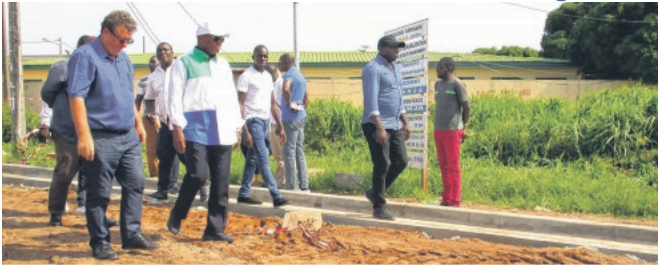
Jean-Fidèle Otandault, satisfait de l'avancement du chantier. ici, samedi dernier en compagnie du DG de SOCO TP, M. Rodovan
