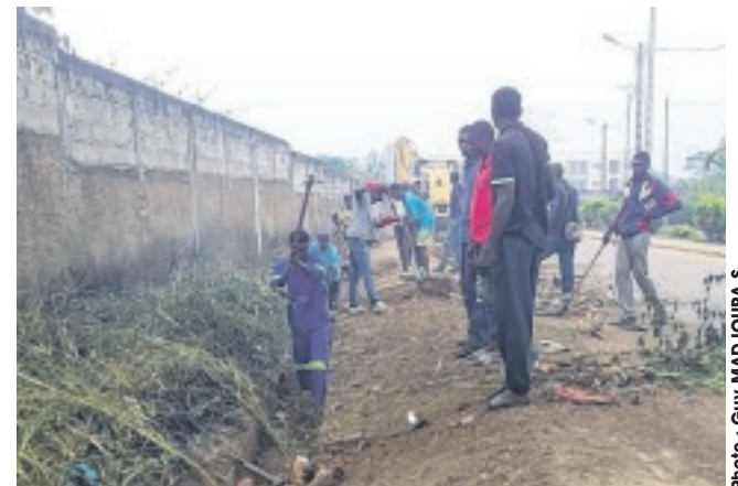
Différents outils sont utilisés pour déboucher les caniveaux.
