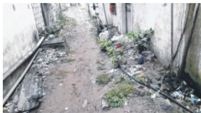
Le type de passage dont l'entretien pose problème.
