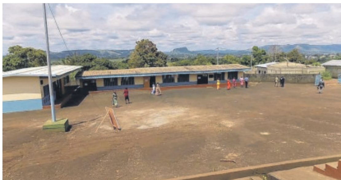
Une des dix écoles rénovées par la société Comilog.
