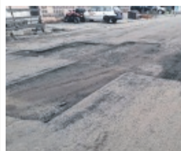
Le point à temps pour éradiquer les nids de poule.
