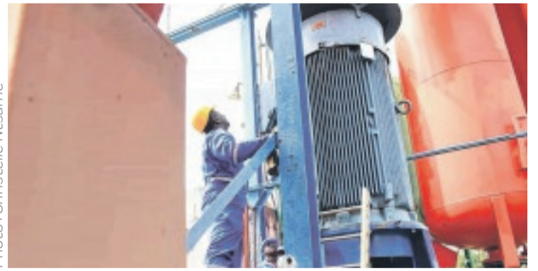
Des agents de la SEEG installant une nouvelle pompe.
