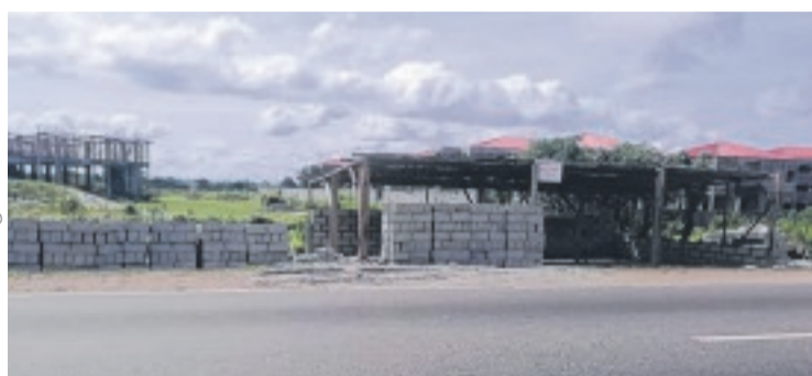
Une briqueterie construite sur le domaine public.
