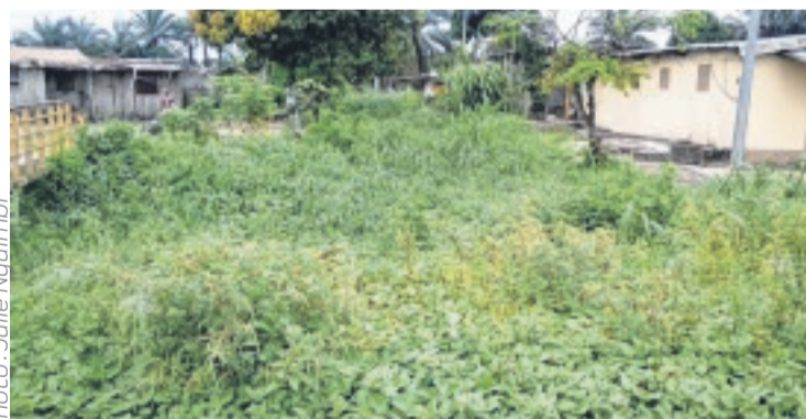
Photo: Julie Ngumbi Les caniveaux sont à nouveau bouchés par les herbes et les débris.
