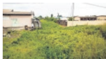
Un canal oublié lors des travaux d'assainissement.
