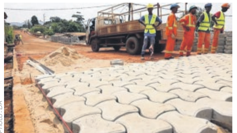
Les travaux de pose des pavés se poursuivent.
