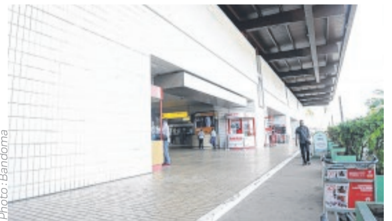
Vue extérieure de l'aéroport de Libreville.
