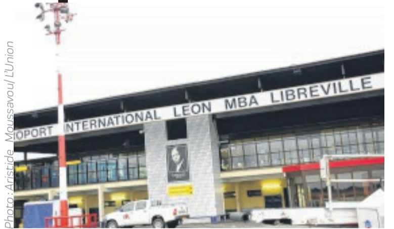
Une vue partielle de l'Aéroport International Léon Mba de Libreville.
