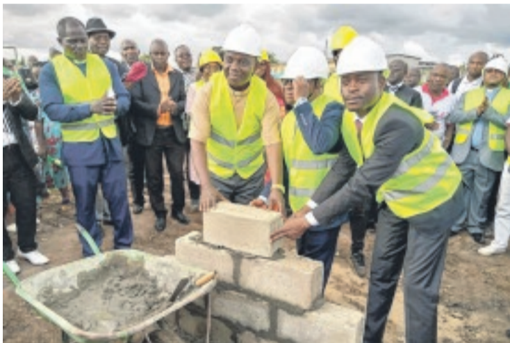
Le lancement des travaux par les autorités de l'EEG.
