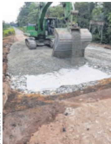
Une vue du chantier.
