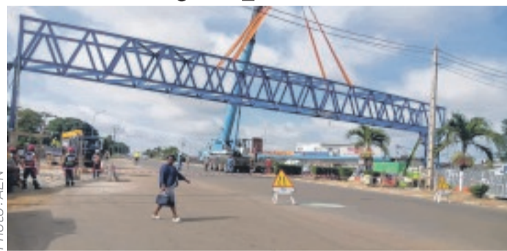
La principale armature est déjà posée. Restent les éléments accessoires.
